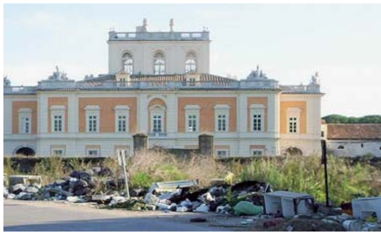
Miseria e nobiltà La reggia di Carditello, bellissima anche nel degrado
